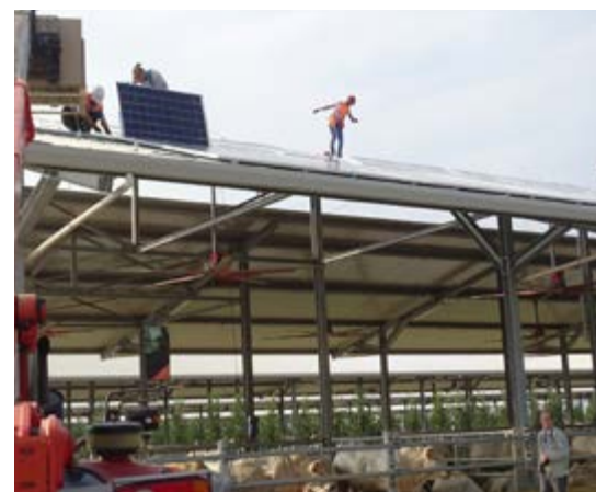
Installazione di pannelli fotovoltaici sui tetti delle stalle di Bonifiche Ferraresi
